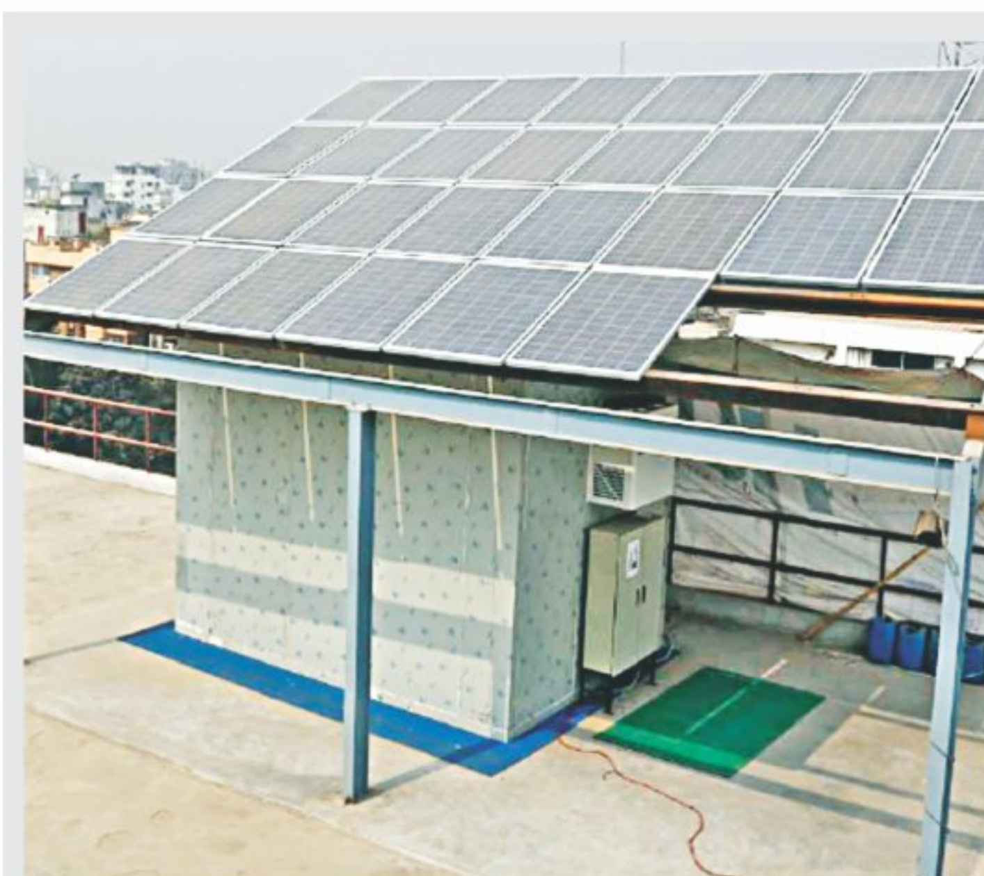
Solar PV-diesel hybrid mini cold storage.
