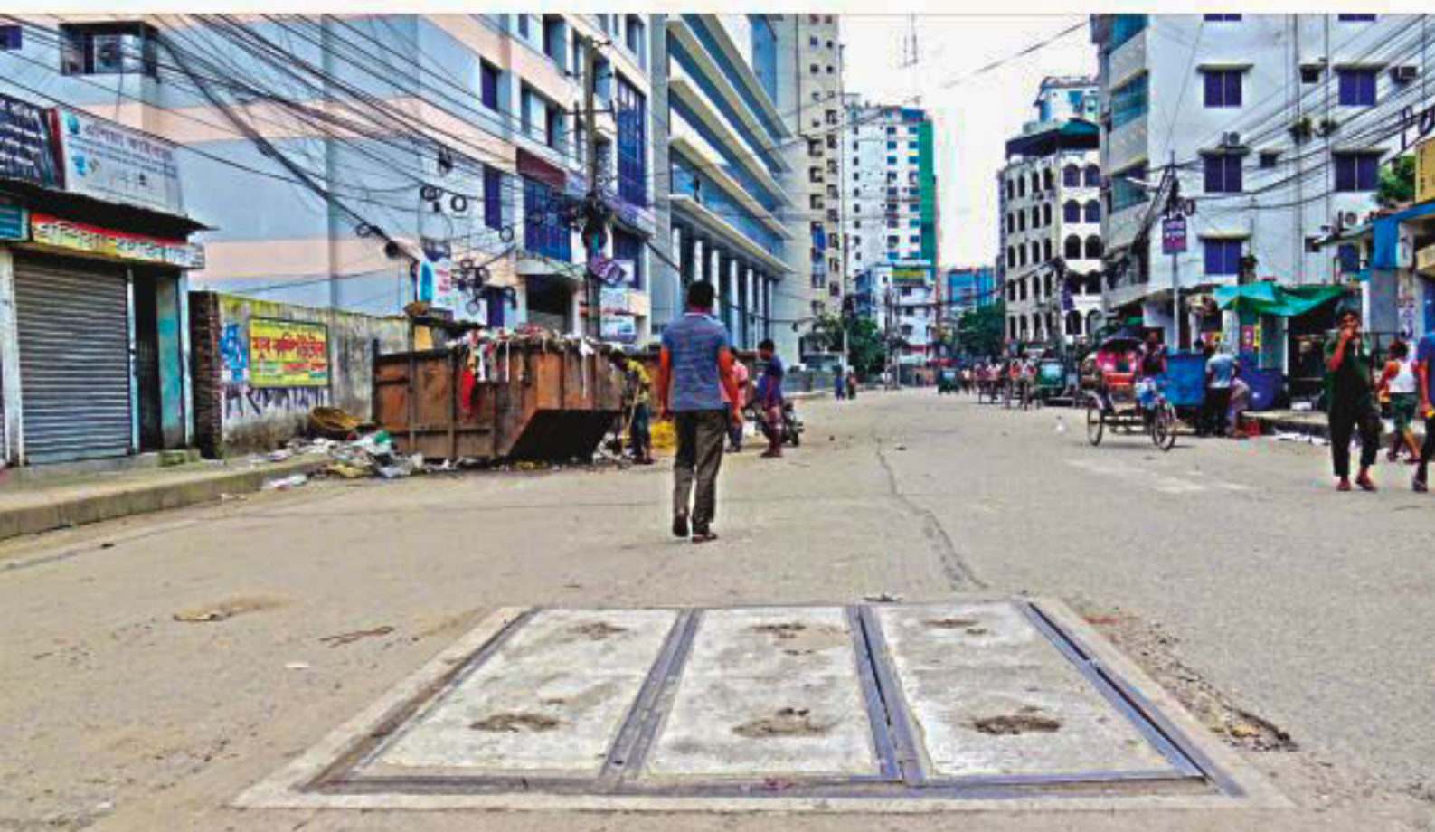
Box culvert on Segunbagicha canal.
